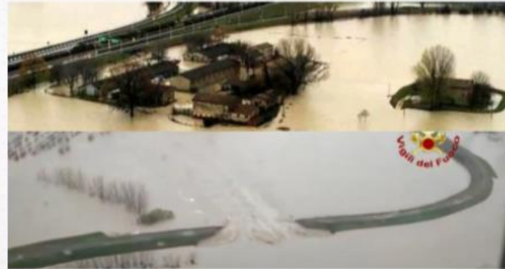
Rotte lungo l'argine destro del fiume Panaro (dicembre 2020)
